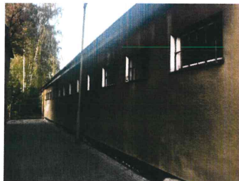
Foto. 2. Elewacja zachodnia budynku C
